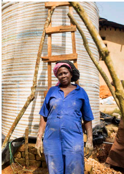
Sie bringt die Dinge gern ans Laufen – am liebsten Wasser: Lydia Kateregga beim Bau einer Regentonne
