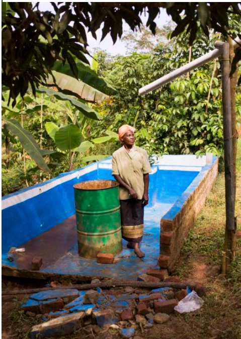
Wasser ist Wohlstand. Und weil ihr Enkel später mal studieren soll, sagt Robina Katabalwa, muss das defekte Bassin der Familie schleunigst repariert werden
